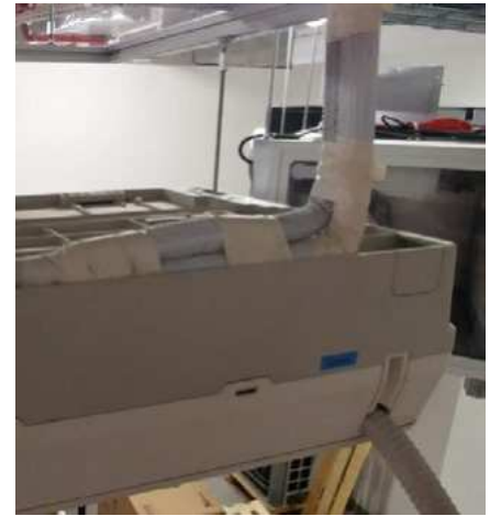
Detail napojení chladivodů a kondenzátu u konvertibilní jednotky
